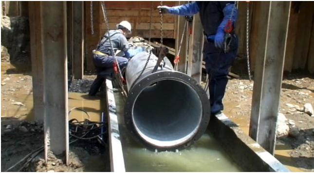
⑤導管接続作業状況
