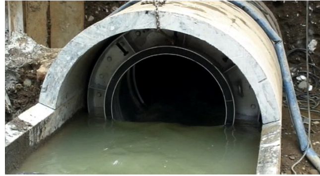
⑧下流側プラグ設置後の流水状況
