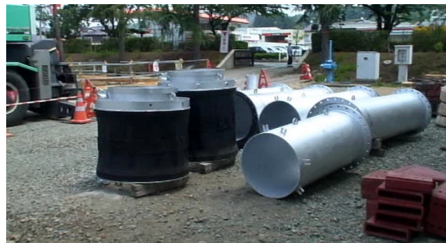
③水替えに使用する プラグ・導管
