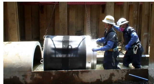
④上流側プラグ設置作業
