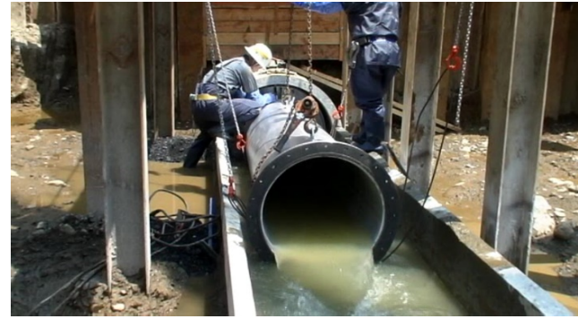
⑥続けて第二、第三の導管を順次設置
