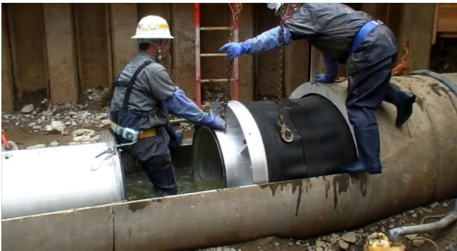
⑦下流側プラグ挿入設置状況
