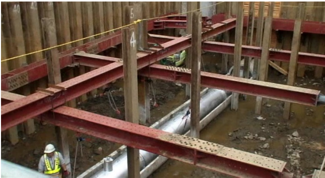
⑪プラグ・導管設置完了状況
