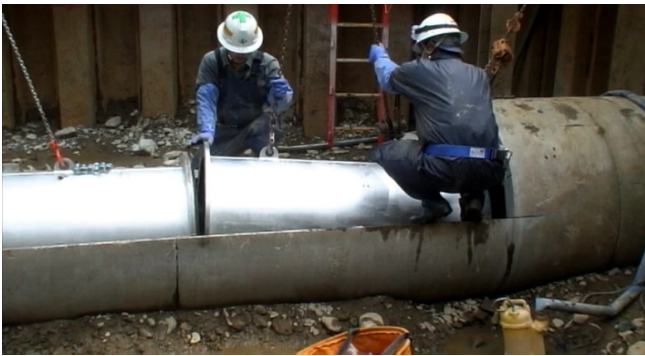
⑨下流プラグと最終導管接続
