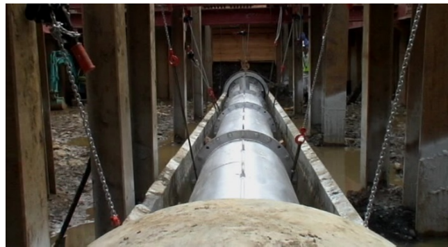
⑩導管接続すべて完了後、上下流のプラグ外袋にエアーを圧入し、流水は導管内を自然流下方式で流れる
