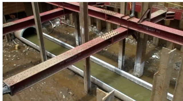
②既設管上部解体撤去完了
