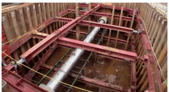
⑫既設管下半ぶを解体完了した状況
