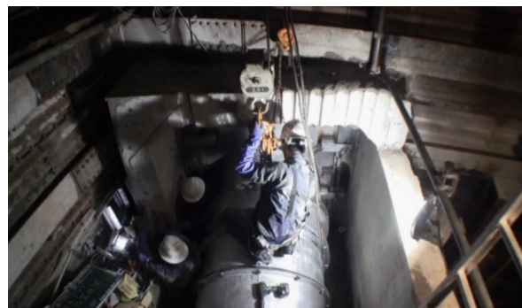
⑧導管接続作業の状況
