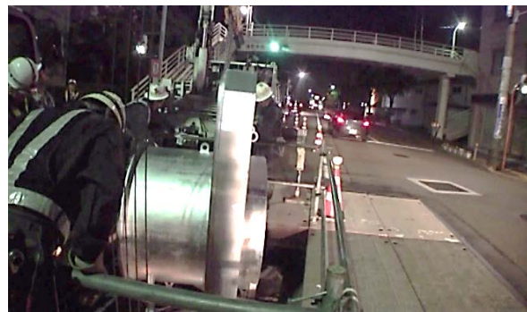
④Box型スーパープラグ 本体荷降し作業状況
