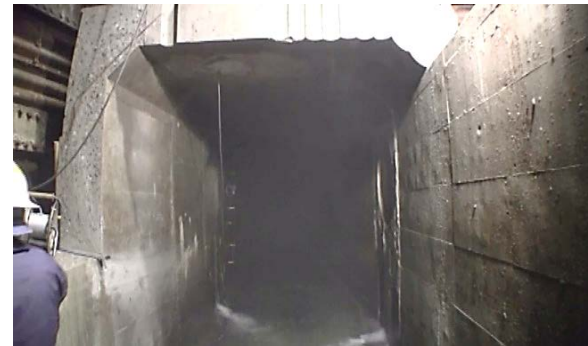
②水替え工事部分Box型水路の状況 w2000×h2600
