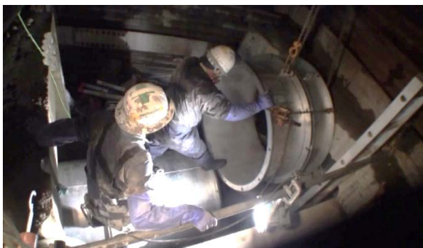
⑤導管を設置位置へ取込み 状況
