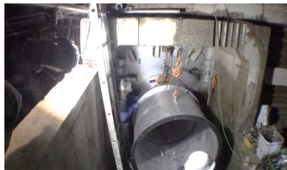
⑥導管接続作業の状況
