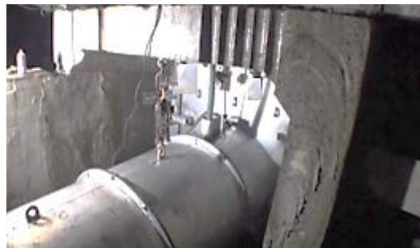
⑩スーパープラグシステム 工法の設置作業完了状況
