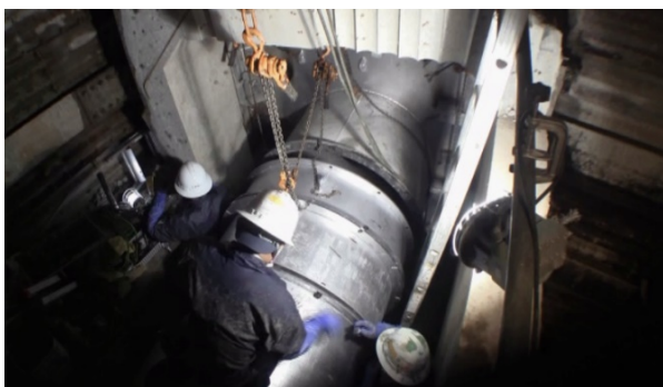
⑦導管接続作業の状況
