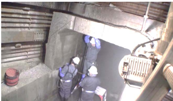
③スーパープラグ設置部分 などの墨出し作業状況
