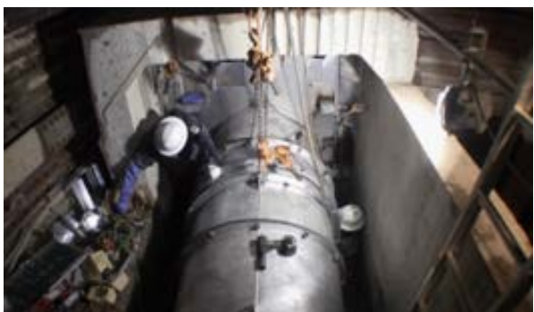
⑨プラグ本体・導管ボルト など最終締付け確認作業
