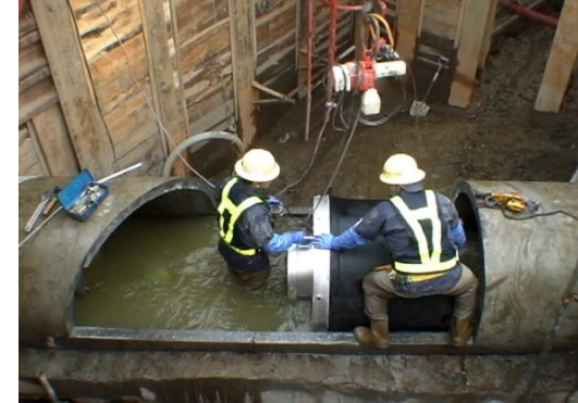
②既設管の上半を新設人孔寸法に合わせ、解体し、撤去します
