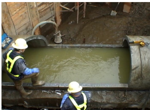
④下流側プラグの流出防止を行いプラグ設置完了
