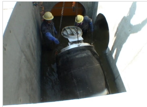
⑩次に、下流側プラグを取外し、上流プラグの止水蓋を流量を確認しながら、徐々に開放し、常水を確認して、上流プラグを取外します 以上の作業で、既設管割込み人孔設置、新設管接続、流路変更が完了します
