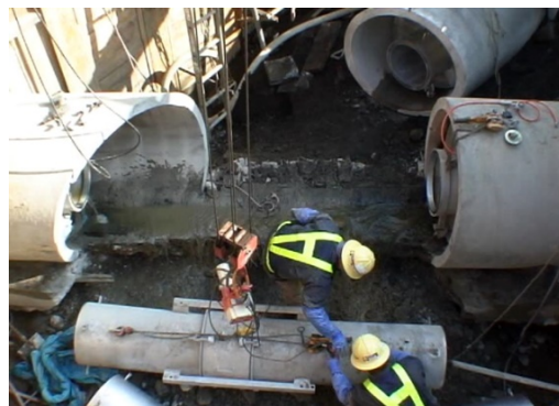
⑦新設管へ逆流防止プラグを設置、既設管上流プラグの止水蓋を閉塞し止水後、直導管を取外し、曲がり導管を既設管上流プラグと新設管逆流防止プラグへ接続します、接続完了後、止水蓋を開放し通水ます
