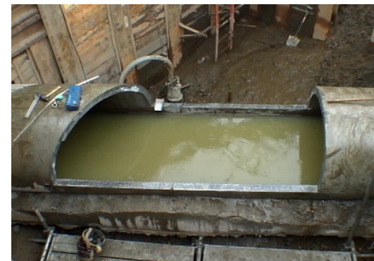
②既設管の上半を新設人孔寸法に合わせ、解体し、撤去します
