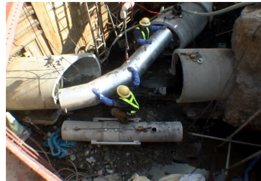
⑦新設管へ逆流防止プラグを設置、既設管上流プラグの止水蓋を閉塞し止水後、直導管を取外し、曲がり導管を既設管上流プラグと新設管逆流防止プラグへ接続します、接続完了後、止水蓋を開放し通水ます
