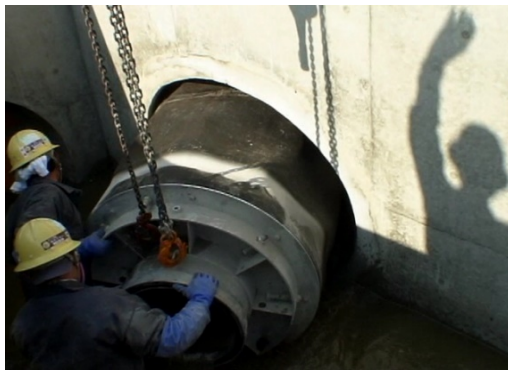
⑩次に、下流側プラグを取外し、上流プラグの止水蓋を流量を確認しながら、徐々に開放し、常水を確認して、上流プラグを取外します 以上の作業で、既設管割込み人孔設置、新設管接続、流路変更が完了します
