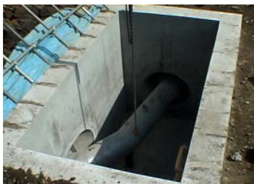
⑨新設人孔、インバート構築、管口補修など完了後、上流プラグの止水蓋閉塞、導管の取外しを行います
