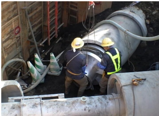
⑦新設管へ逆流防止プラグを設置、既設管上流プラグの止水蓋を閉塞し止水後、直導管を取外し、曲がり導管を既設管上流プラグと新設管逆流防止プラグへ接続します、接続完了後、止水蓋を開放し通水ます
