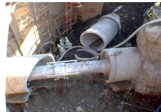
⑥次に、既設管下半を解体（新設管布設も完了）
