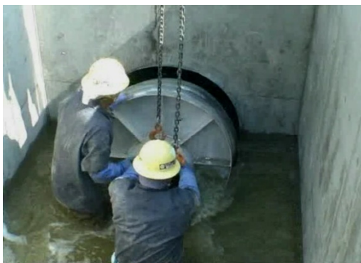
⑩次に、下流側プラグを取外し、上流プラグの止水蓋を流量を確認しながら、徐々に開放し、常水を確認して、上流プラグを取外します 以上の作業で、既設管割込み人孔設置、新設管接続、流路変更が完了します
