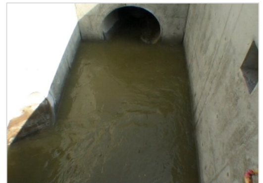
⑩次に、下流側プラグを取外し、上流プラグの止水蓋を流量を確認しながら、徐々に開放し、常水を確認して、上流プラグを取外します 以上の作業で、既設管割込み人孔設置、新設管接続、流路変更が完了します
