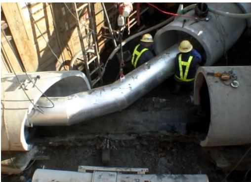
⑧曲がり導管接続完了後、既設管上流プラグの止水蓋を解放、通水、流路変更完了します、続いて、新設人孔の構築を行います
