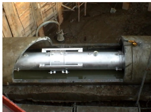
⑤上下流プラグへエアーを圧入、上流プラグの止水蓋を閉塞し、水のない状態で導管を接続、接続完了後、止水蓋を開放し通水ます
