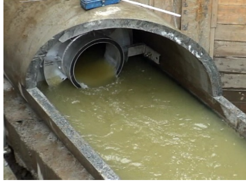
③上部開口からエアーを減圧した状態で上下流プラグを設置します（止水蓋は解放状態）
