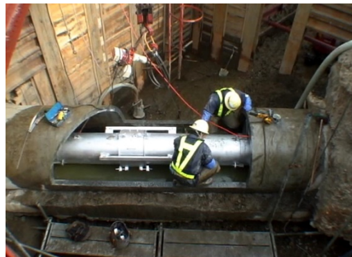
⑤上下流プラグへエアーを圧入、上流プラグの止水蓋を閉塞し、水のない状態で導管を接続、接続完了後、止水蓋を開放し通水ます
