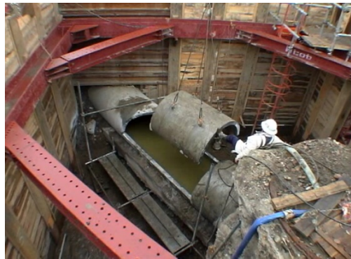
②既設管の上半を新設人孔寸法に合わせ、解体し、撤去します
