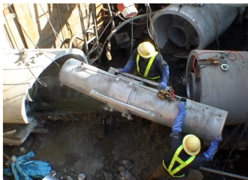
⑦新設管へ逆流防止プラグを設置、既設管上流プラグの止水蓋を閉塞し止水後、直導管を取外し、曲がり導管を既設管上流プラグと新設管逆流防止プラグへ接続します、接続完了後、止水蓋を開放し通水ます
