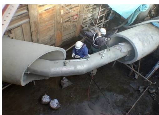
⑧曲がり導管接続完了後、既設管上流プラグの止水蓋を解放、通水、流路変更完了します、続いて、新設人孔の構築を行います
