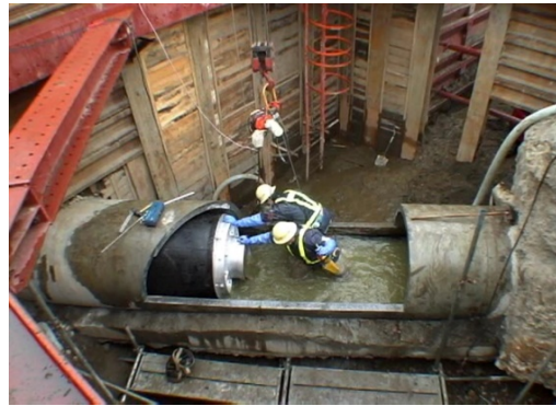
③上部開口からエアーを減圧した状態で上下流プラグを設置します（止水蓋は解放状態）
