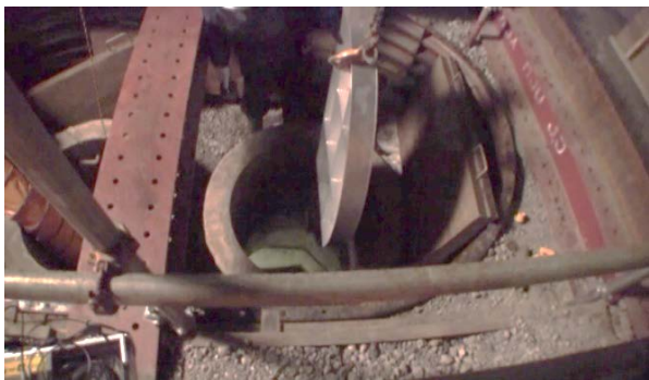
③搬入開口φ900mmからの 機材取込み状況
