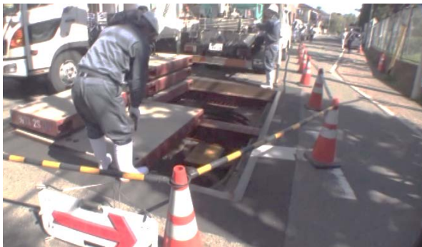
①工事部分の覆工状況、この部分から機資材の搬入を行った
