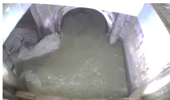
⑩人孔内の更生工事が完了し、 プラグ・導管の撤去搬出後 人孔内の流水状況
