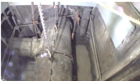
⑨人孔内の更生工事が完了 した状態
