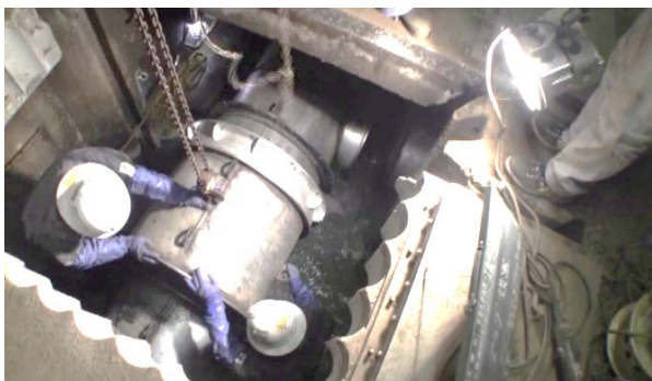
⑤組立てられたスーパー プラグを人孔内へ取込み、 設置作業状況
