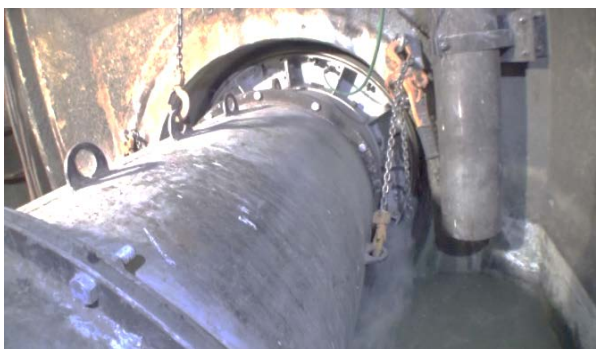
⑦組立てられたスーパー プラグ・導管の状況
