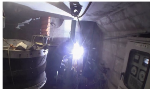
④搬入された機材は地下1階 部分で組立を行った
