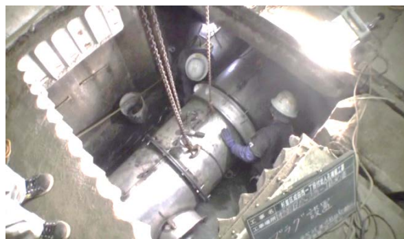
⑥導管の接続設置作業状況
