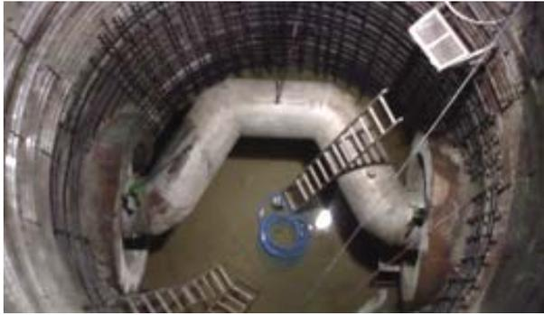
③既設シールド管上下流のプラグへU型導管の接続が完了、上下流へプラグの外袋へエアを圧入、水は導管内を流れ工事部分は水のない状態となる
