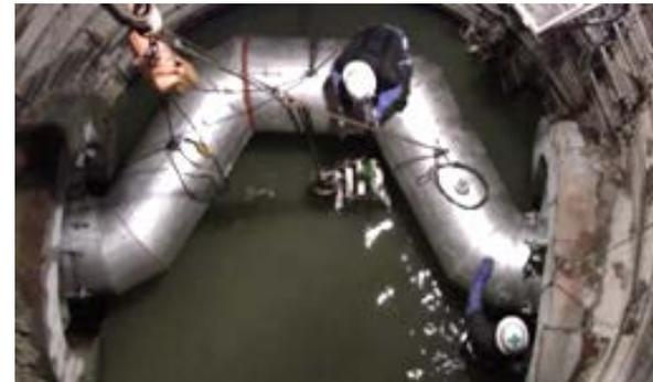
⑥既設シールド管上流側プラグの耐圧開閉蓋を閉塞し、一時止水の状態、U型導管取外し準備作業状況
