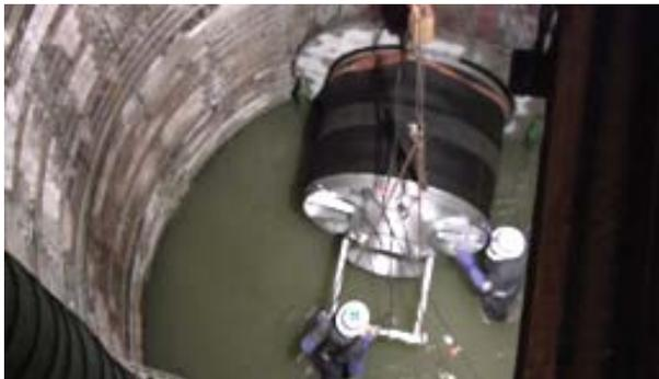
①既設シールド管 上流側へφ1800用プラグ設置作業状況
