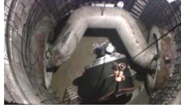
④推進管が到達し、推進機材を引揚げ、新設管へφ1800用プラグ設置準備状況
