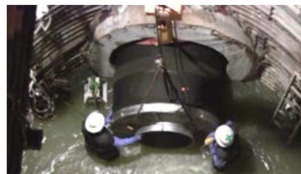
②既設シールド管 下流側へφ1800用プラグ設置作業状況
