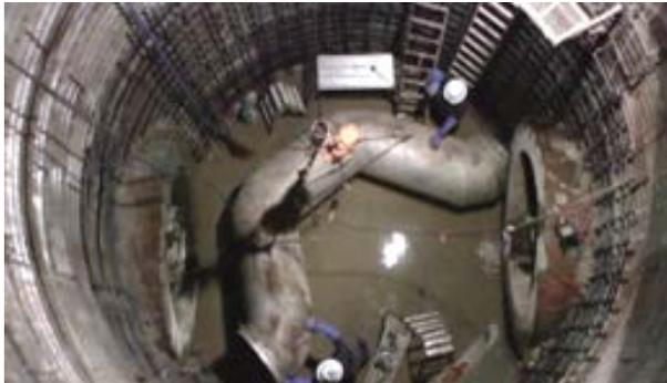
⑦U型導管取外し、搬出作業状況
