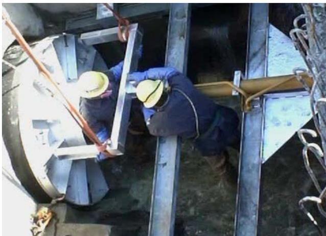
③既設管の流量が多いため、プッシャーを使用して、スーパープラグを所定の位置まで挿入する
