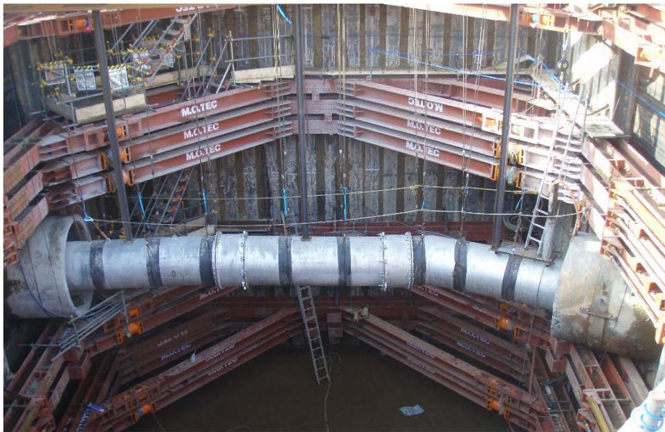
【地下掘削が進み導管は吊防護状態】
