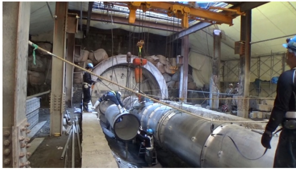
【手順21】 上下流プラグ本体にΦ1000mm導管を接続する。
