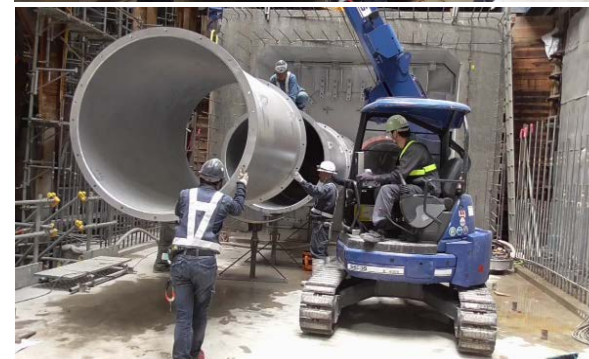
【説明2】 下流側流路変更用角形プラグ 4500mm*4500mmBox用 導管Φ1000mm接続用1式 導管Φ1600mm接続用1式
