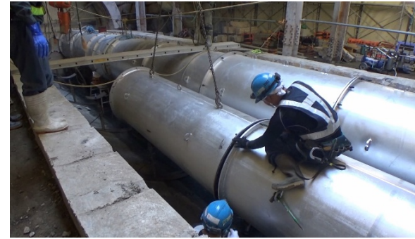
【手順22】 Φ1000mm導管接続作業。
