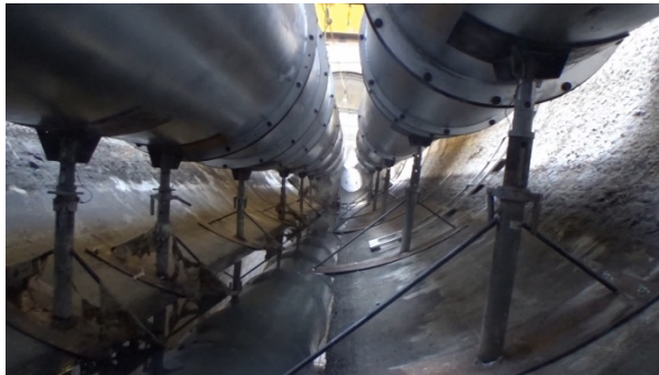
【手順23】 導管接続完了後、プラグ本体のΦ1000mm耐圧蓋を解放しΦ1000mm導管内へも流水を流します。 写真はΦ1600mm、Φ1000mm導管の受架台の設置状態。
